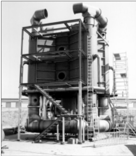
Afbeelding 4: regeneratieve naverbrander in aanbouw
