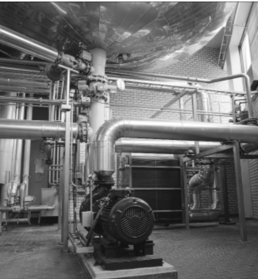
Afbeelding 7: een pomp met elektromotor
