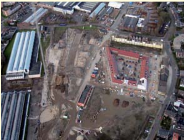
Overzichtsfoto saneringswerkzaamheden (foto: Projectbureau Hart van Zuid)
