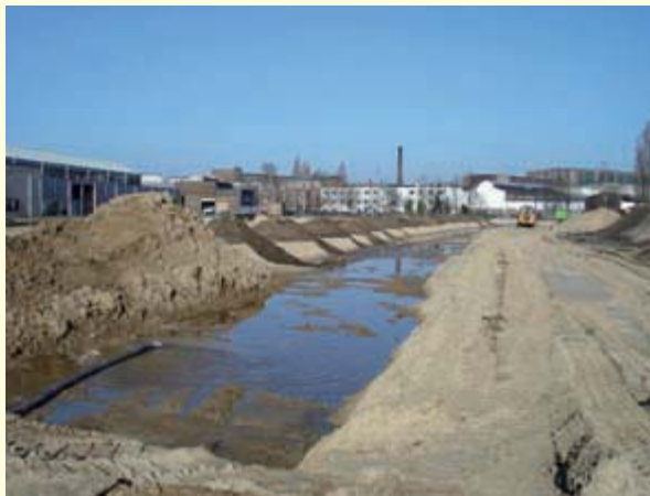
Aanleg waterpartij (foto: Projectbureau Hart van Zuid)
