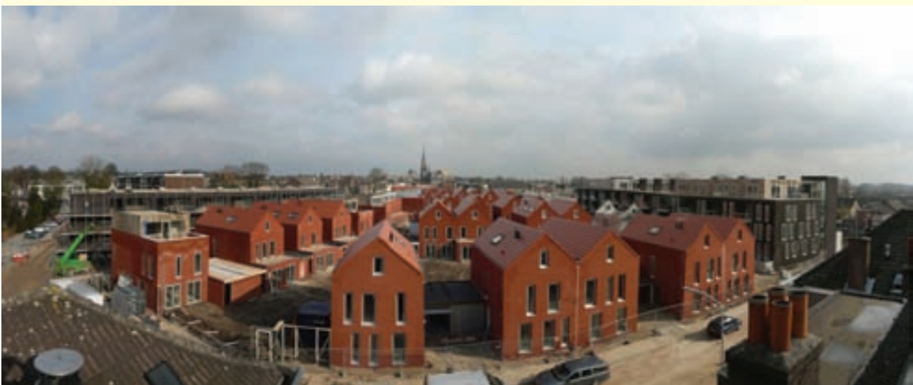
De Velpsche Veste in aanbouw – situatie maart 2009 (foto: Ari de Kok)
