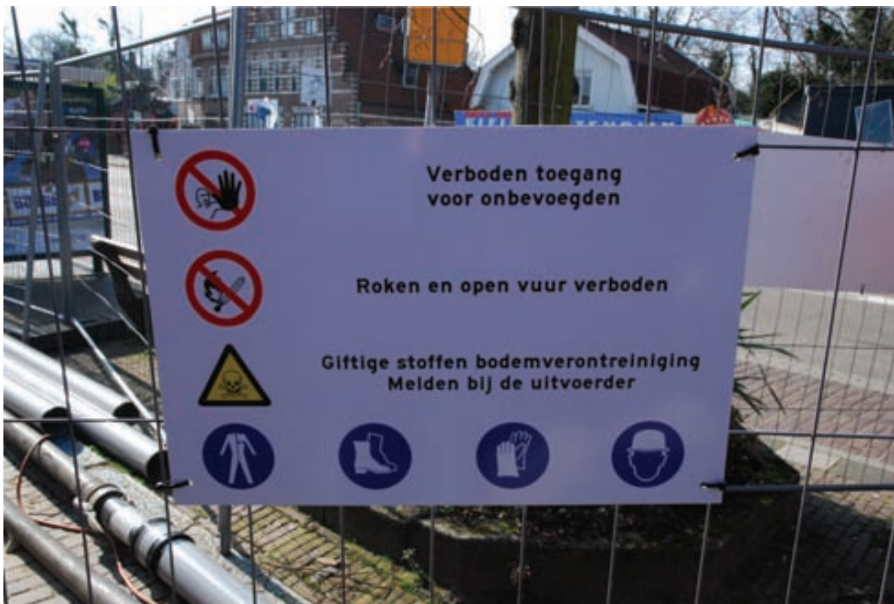
Sanering bodemverontreiniging van voormalig benzinstation in het centrum van Bilthoven
