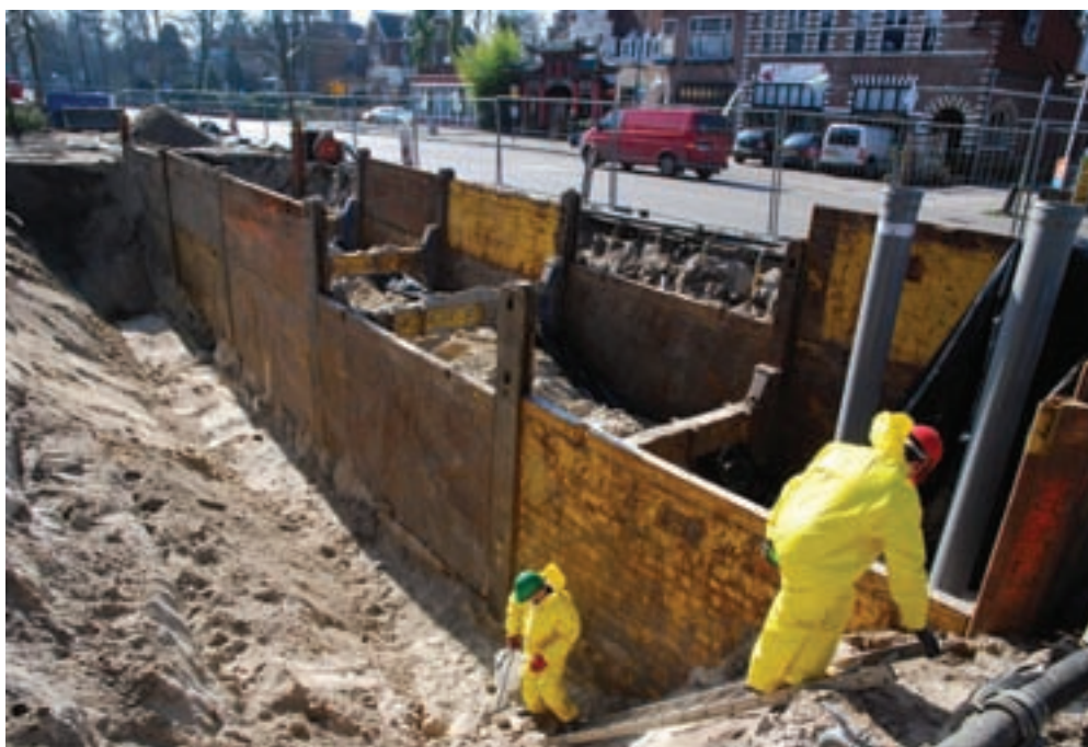
Sanering bodemverontreiniging van voormalig benzinestation in het centrum van Bilthoven
