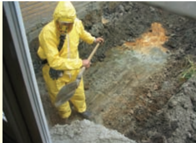
Asbestsanering in 2004 (foto: bewoners Zwanenstraat, Goor)
