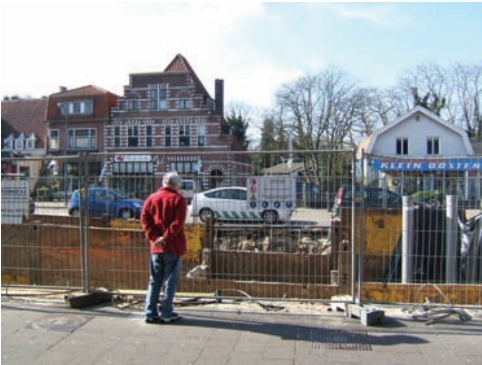
Sanering bodemverontreiniging van voormalig benzinstation in het centrum van Bilthoven
