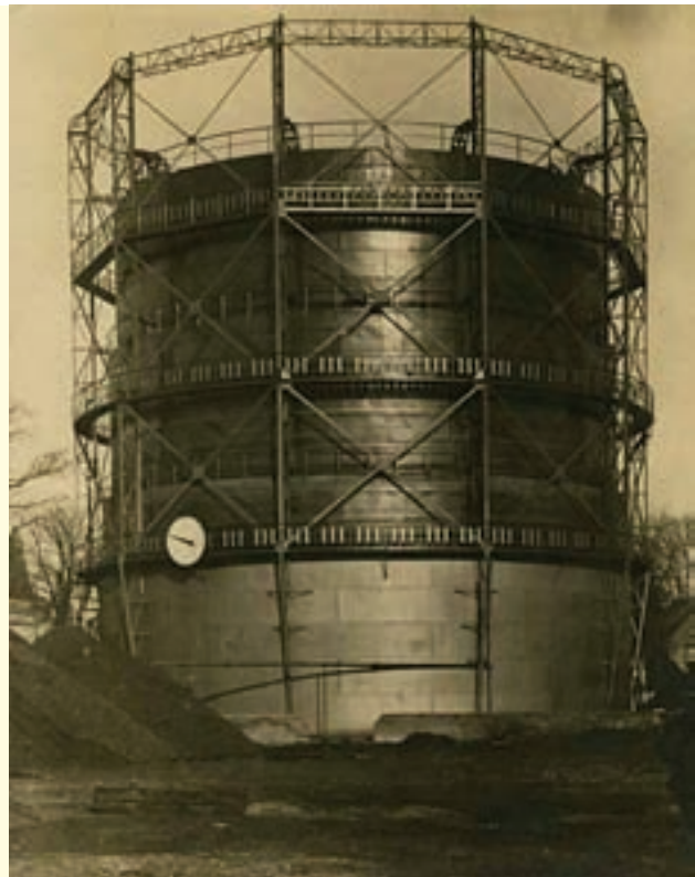
De oude gasfabriek in Velp (fotograaf onbekend)
