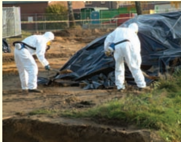
Asbestsanering in 2004 (foto: bewoners Zwanenstraat, Goor)
