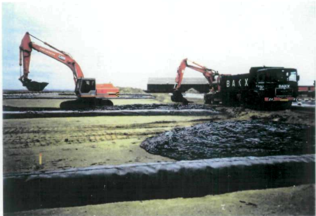
Figuur 6 - Foto van het opbrengen van de baggerspecie
