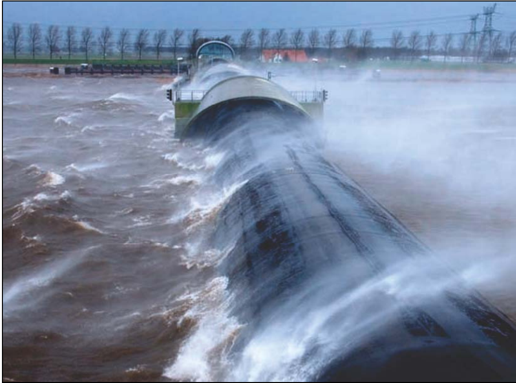
Figuur 15: De balgstuw bij Ramspol gesloten bij hoogwater. Bron: Waterschap Groot Salland, folder over de balgstuw, www.wgs.nl
