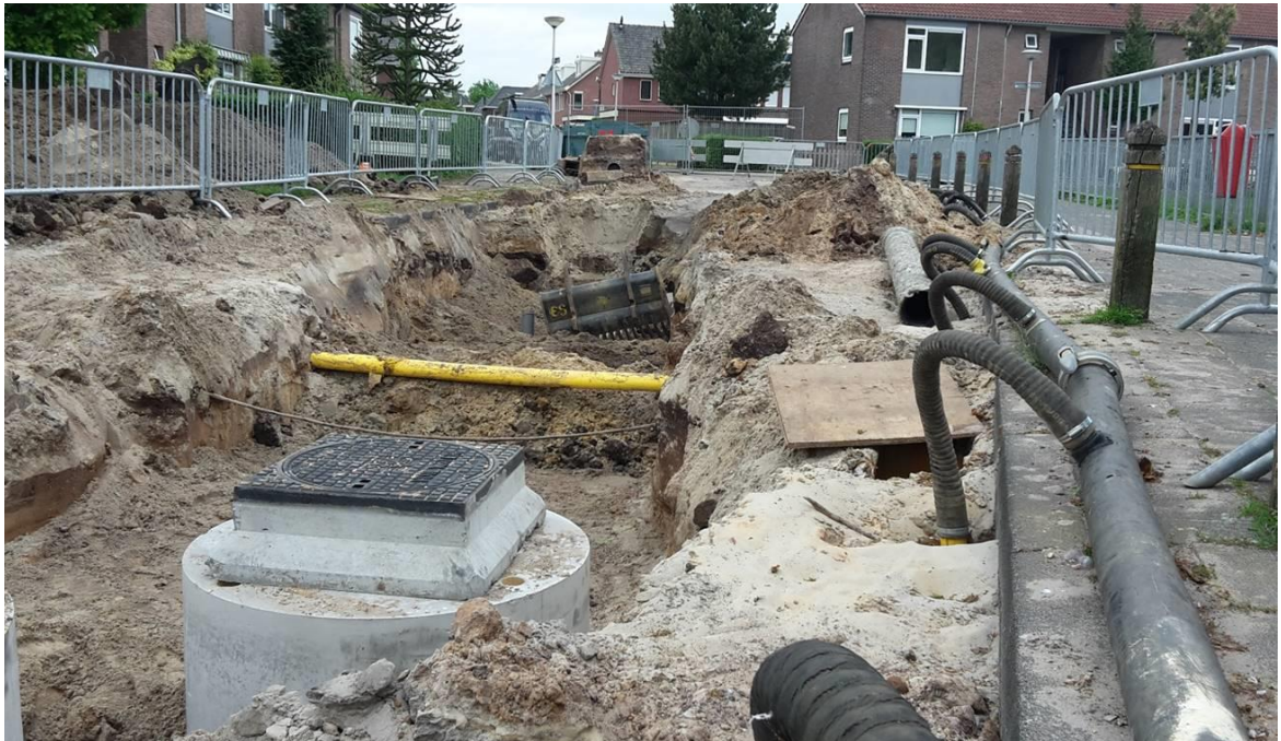
Figuur 6. Voorbeeld van een bemaling bij een rioolvervangning, waarbij ook (niet zichtbaar) retourbemaling is toegepast om tijdelijke grondwaterdalingen en schade als gevolg daarvan te voorkomen. Bron Wareco.
