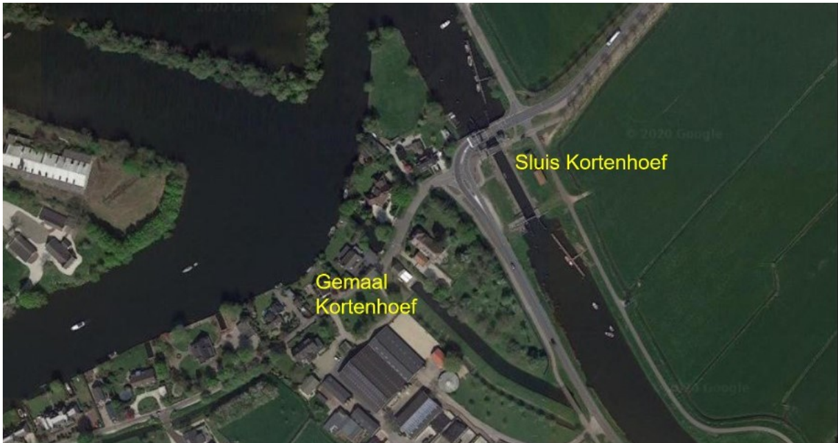
Figuur 5.2 Ligging sluis Kortenhoef en gemaal
