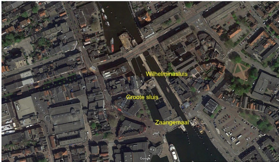
Figuur 7.1 Ligging gemaal Zaandam en de Wilhelminasluis
