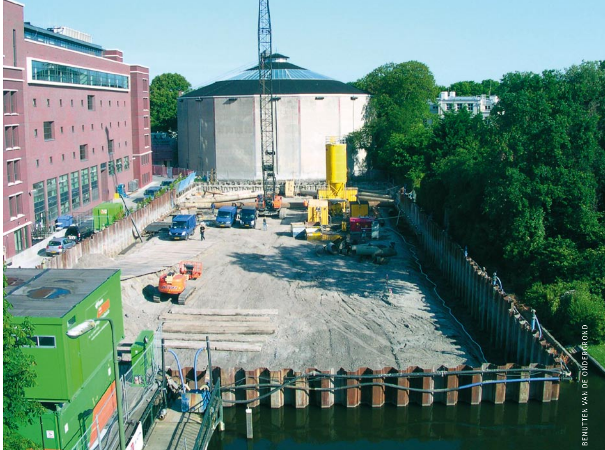
Figuur 3. Rotonde Panorama Mesdag, compensation grouting equipment staat voor de rotonde (foto Almer van der Stoel).
