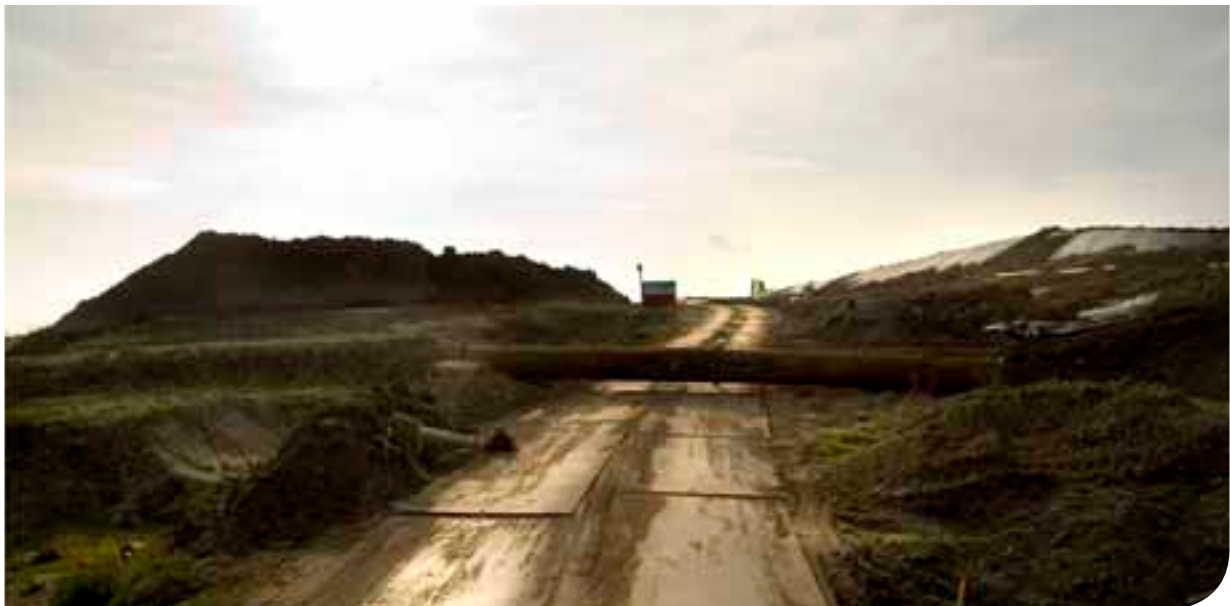
Werk in uitvoering
