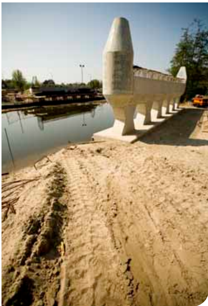
Aanleg van een brug, Woerden
