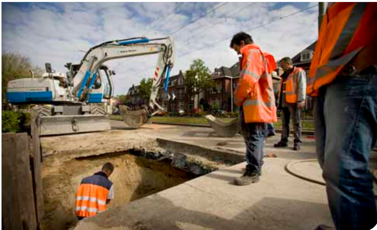
Grondwerkzaamheden, Den Haag
